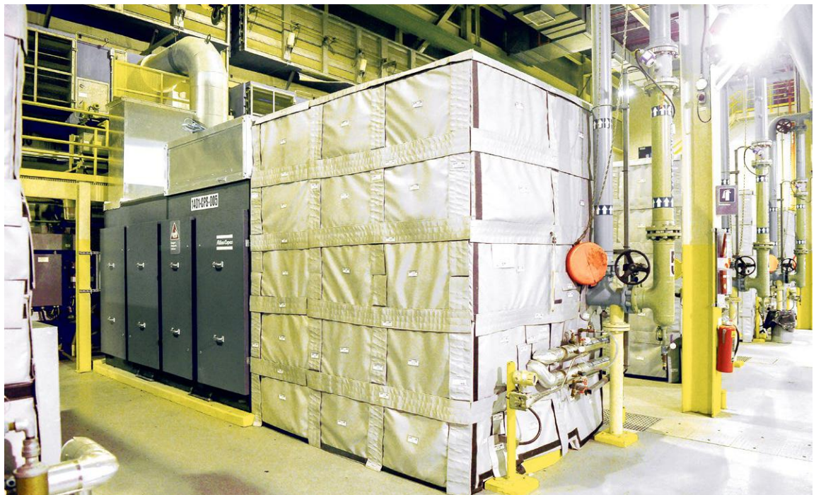
L'insonorisation des compresseurs a considérablement amélioré la santé et la sécurité des employés au site AP40.
